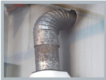
Los artefactos a gas, por su propia naturaleza de funcionamiento, producen gases de combustión que deben ser derivados al exterior.
